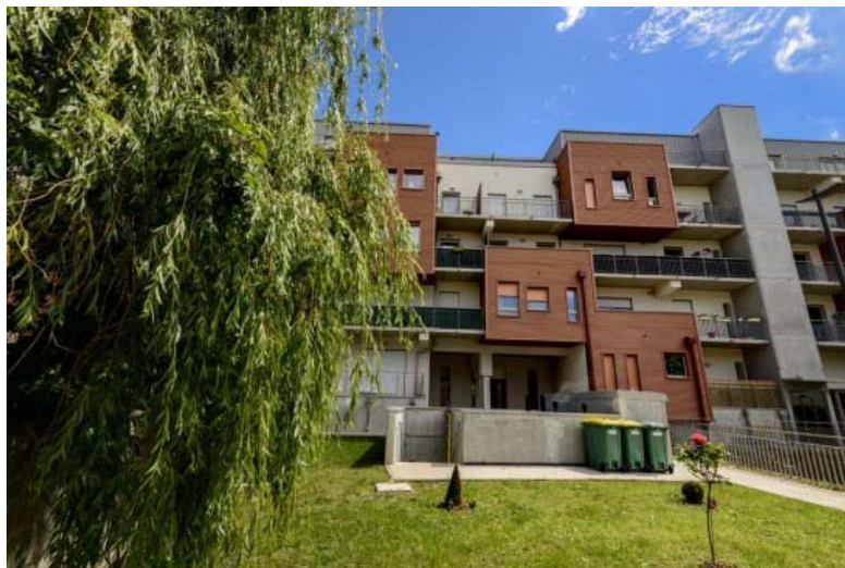
claude.philippot@yahoo.fr - La façade arrière de l'îlot Oudeville après sa transformation en un style contemporain
