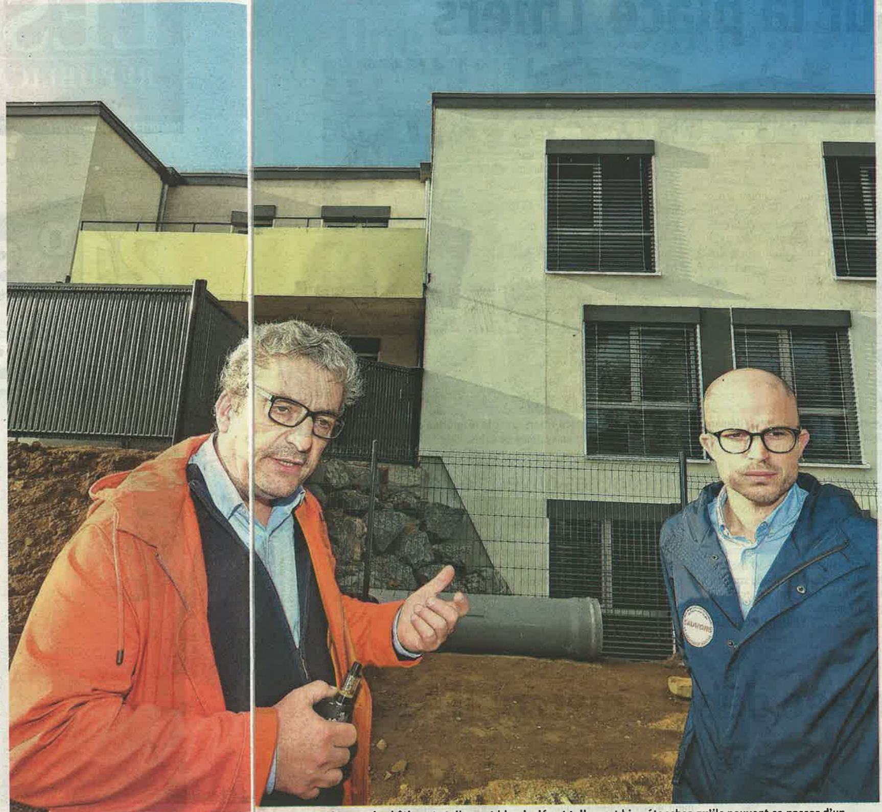
« Ce sont des bâtiments tellement bien isolés et tellement bien étanches qu'ils peuvent se passer d'un chauffage traditionnel », explique l'architecte Rolf Matz (à gauche). Photos Cédric JACQUOT
