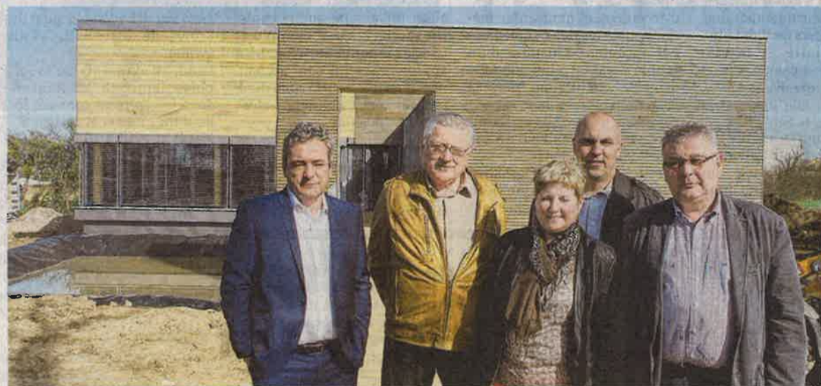
Le bâtiment comporte 11 bureaux qui seront loués à des entreprises œuvrant dans le passif (ingénierie, architecture). La fédération française de construction passive y organisera des formations pour les artisans et concepteurs. Les particuliers pourront aussi se renseigner dans l'espace info-énergie qui y sera aménagé. La communauté de communes de la région de Saverne a financé la construction pour 1,46M€ HT, soit un surcoût évalué à 10 % par rapport à un bâtiment classique, qui devrait être rattrapé par l'économie générée sur les coûts de fonctionnement. Le projet totalise des subventions à hauteur de 645 800 €.
