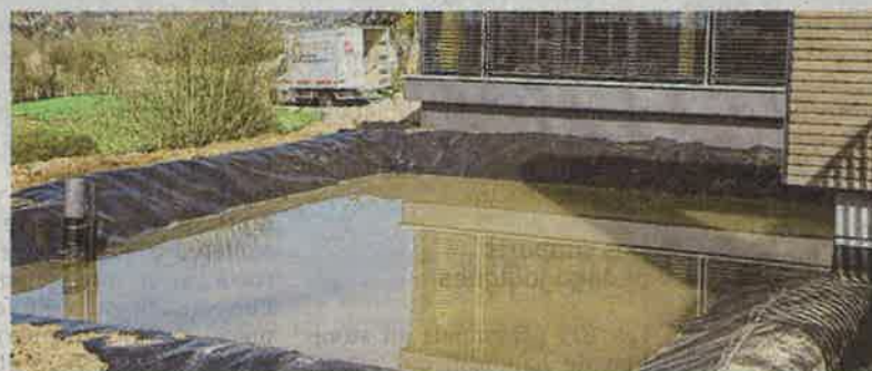
Le bassin de rétention, à l'entrée, sera rempli par environ 30m 3 d'eau, pour y
