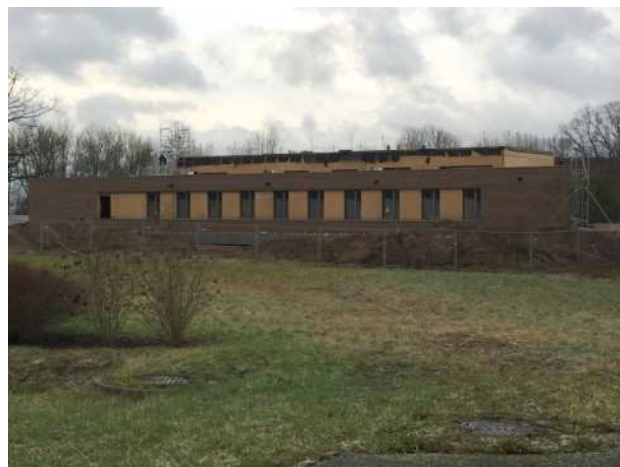
© Rolf Matz Architecture - Le bâtiment de 550 m 2 présente des besoins en chauffage estimés à 9 kWh/m 2 .an
