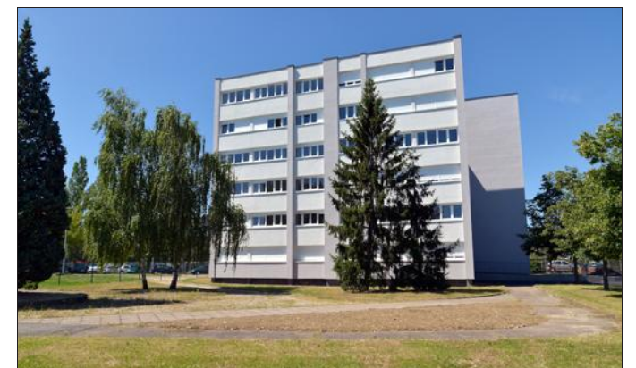
■ Le Chardon Rouge à Tomblaine : un nouveau chauffage par géothermie.
