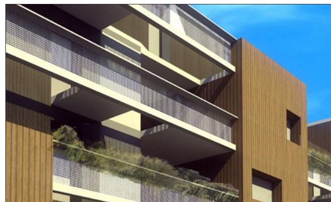
■ L'arrière de l'îlot Oudeville. La façade a été épaissie pour augmenter la surface habitable. Côté rue, le bâtiment conserve son cachet des années 30.
